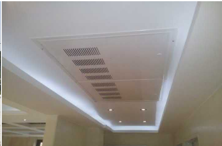
۵- دریچه بازدید پانل داخلی داکت اسپلیت
