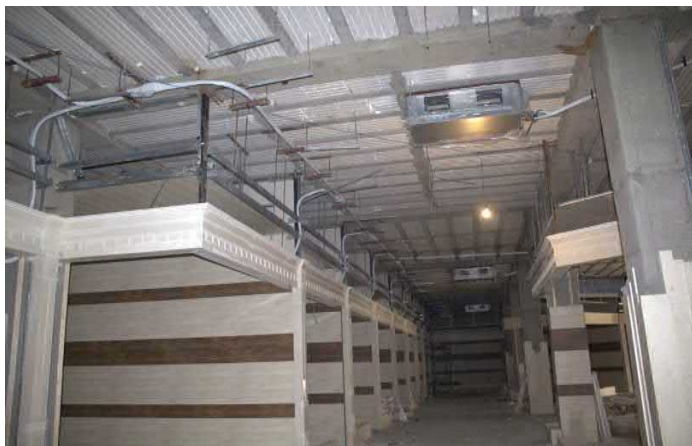
۳- اجرای لوله کشی مسی از محل نصب پانل های داخلی به محل نصب پانل خارجی
