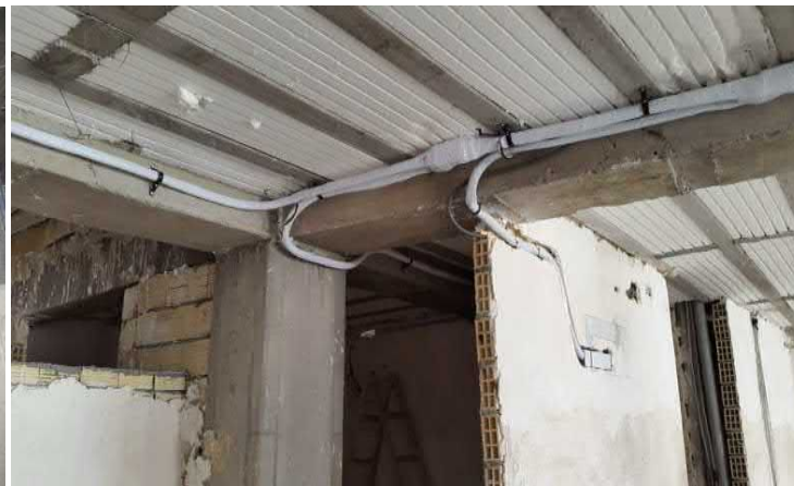
۲- اجرای لوله کشی پانل داخلی
