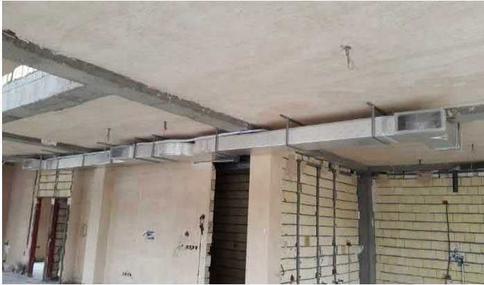
۳- کانال کشی با ورق پیش عایق شده پال
