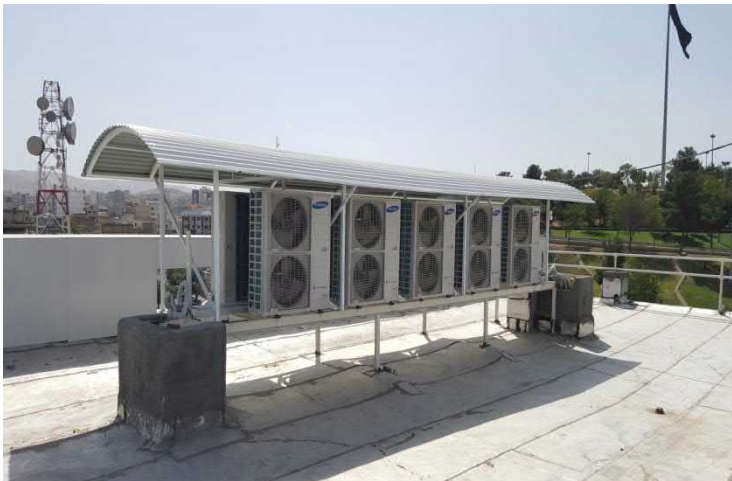
۶- شاسی کشی پانل خارجی و نصب آن در پشت بام
