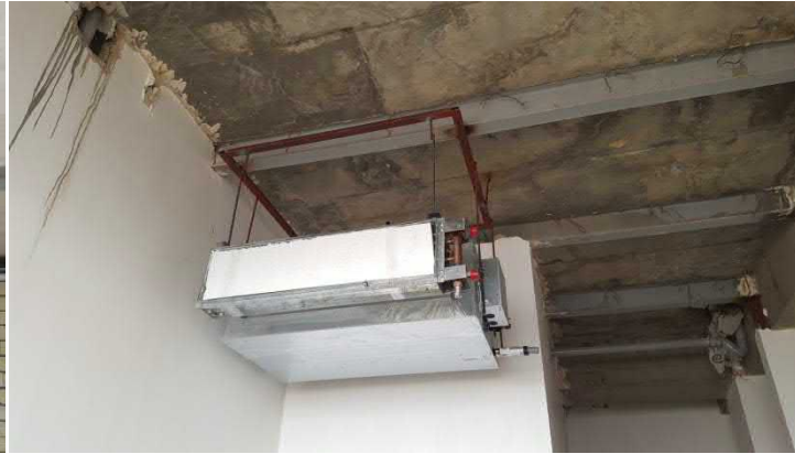
۲- نصب دستگاه پانل داخلی و اجرای لوله کشی مسی
