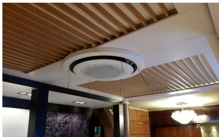
۷- نصب پانل داخلی مدل سقفی
