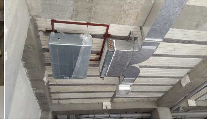
۱- نصب کانال به کویل آبگرم پانل داخلی
